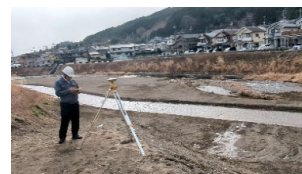
①③GNSS測量機(点名:)
